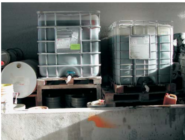
Depósito de combustible en zona cubierta y de solera estanca con pendiente hacia un punto que permite la recogida
