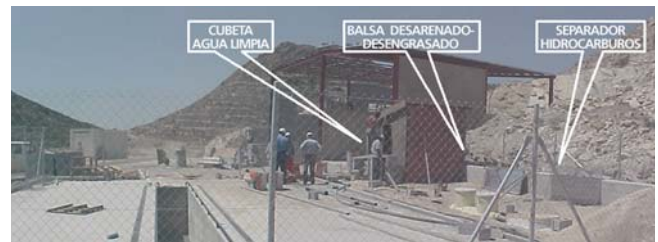
Foso de mantenimiento y sistema de depuración
