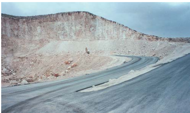
Pistas asfaltadas para el acceso a los frentes
