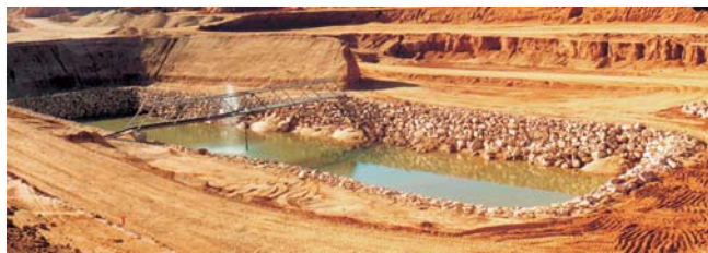
Balsa de agua clarificada para la recirculación en el proceso. Bordes acondicionados con piedra de escollera.
