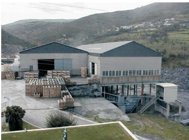
Vista general de la planta
