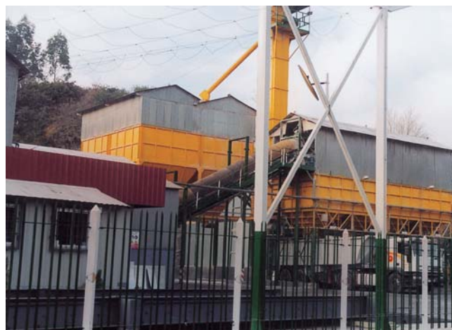
Planta de tratamiento carenada que refleja la inquietud de la empresa por la calidad ambiental y la buena apariencia de las instalaciones
