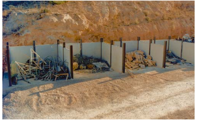
Compartimentos para la recogida selectiva de residuos
