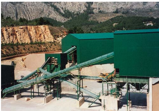
Planta de tratamiento concebida para su integración en el entorno: instalaciones carenadas, cintas transportadoras con capotaje, edificios del mismo color
