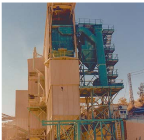
Instalación carenada para confinar el polvo y el ruido
