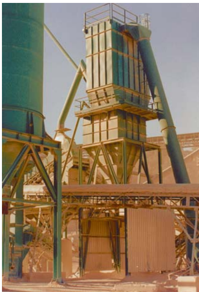
Sistemas de captación de polvo en vía seca
