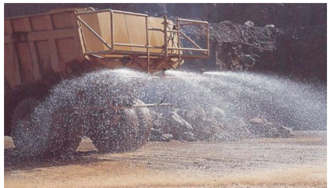
Mantenimiento de las pistas en buen estado
