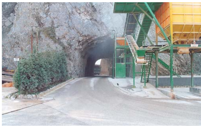
Vista del túnel de acceso a la plaza de cantera. Acceso de camiones y paso de cintas transportadoras
