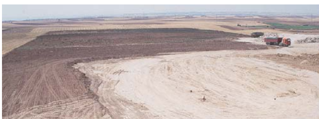
Etapas finales de la restauración del hueco
