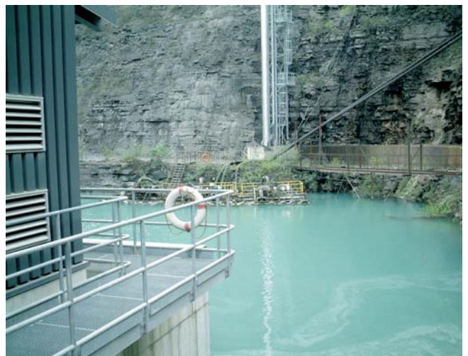
Estación de bombeo de agua para consumo humano, situada en el interior de una cantera
