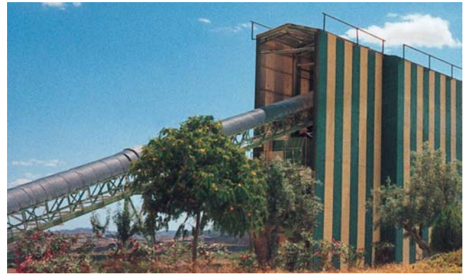
Planta de tratamiento carenada
