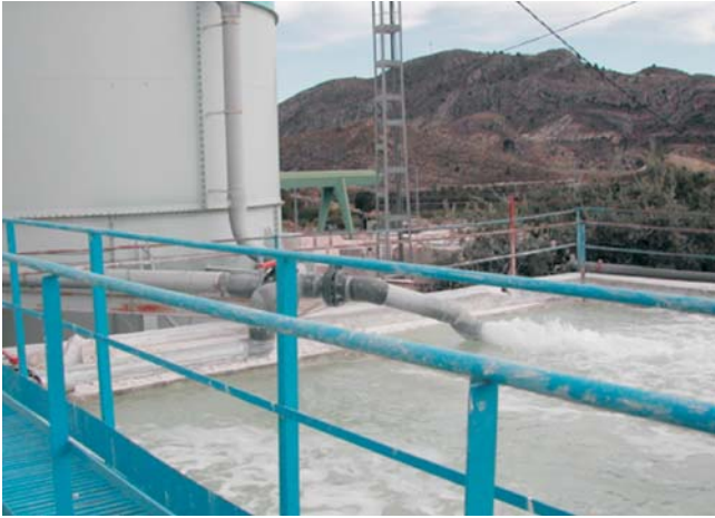
Tratamiento de clarificación del agua de proceso
