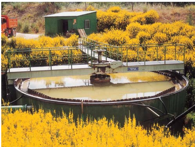
Decantador de lodos integrado en la vegetación circundante
