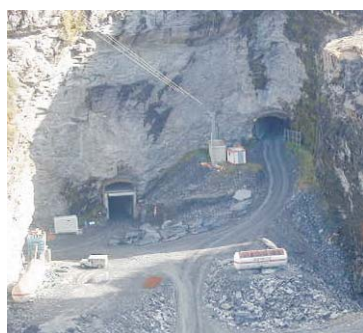
Vista de las dos galerías acceso
