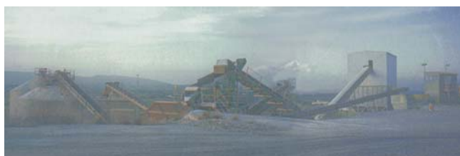
Vista general de la planta
