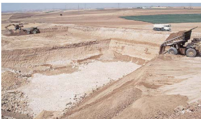
Vista de los trabajos de relleno
