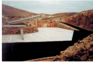
Zona de acopios totalmente pavimentada
