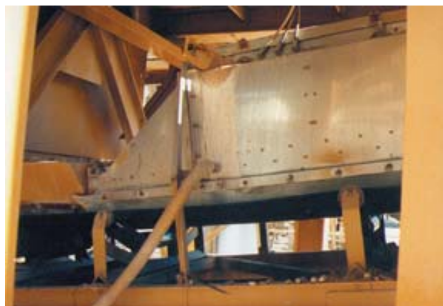
Detalle de los dispositivos de control del polvo
