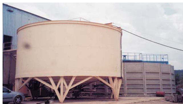
Tanque espesador en primer plano y tanque pulmón al fondo
