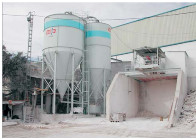
Silos y filtro prensa
