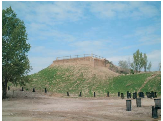
Antigua estructura del primario reconvertida en mirador. Detalle de la replantación
