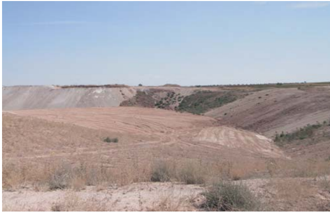
Vista general de los taludes reacondicionados
