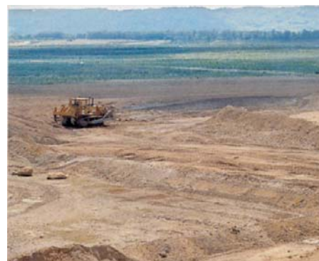
Perfilado definitivo del relleno de un antiguo hueco de explotación
