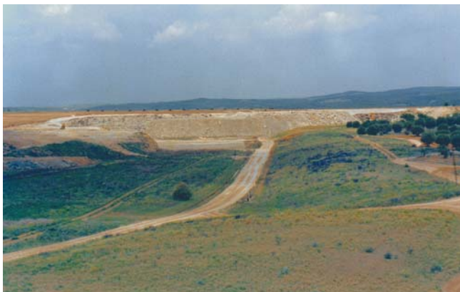
Vista general de las áreas restauradas
