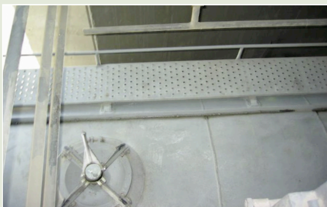
Figura 12. 6. Riesgo apertura de las tapas
