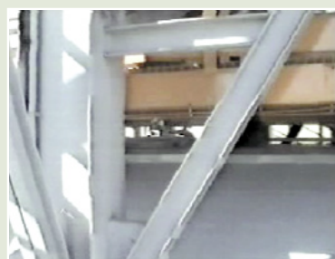
Figura 12. 16. Adaptación al techo de la cisterna
