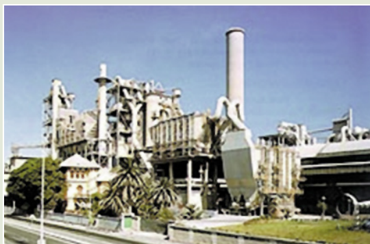
Figura 11. 2. Fábrica en proceso de ampliación
