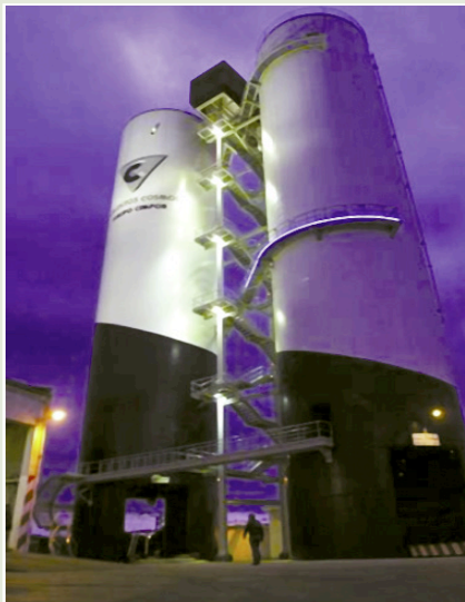
Silos de cemento a granel
