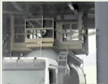
Figura 12. 9. Plataforma bajo silo de cemento para carga de cisternas
