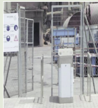
Control de accesos
