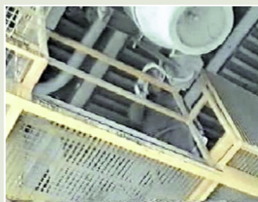
Figura 12. 14. Tareas de mantenimiento
