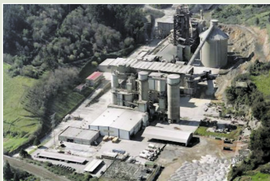
Figura 11. 3. Fábrica en funcionamiento
