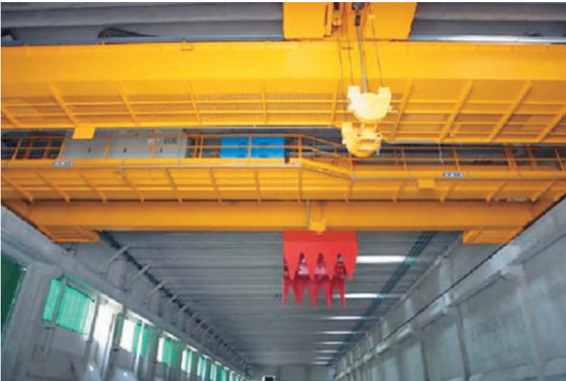
Foto 2.1. Puentes grúa y cazo para manipular RSU y asimilables. (Fuente: ECODECO).
