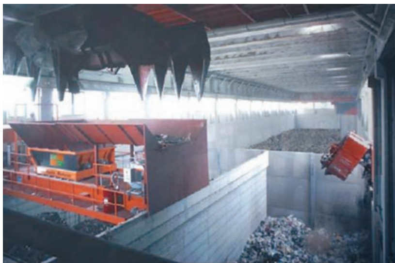
Foto 2.3. Vista del interior: descarga, trituración y zona de biosecado. (Fuente: ECODECO).
