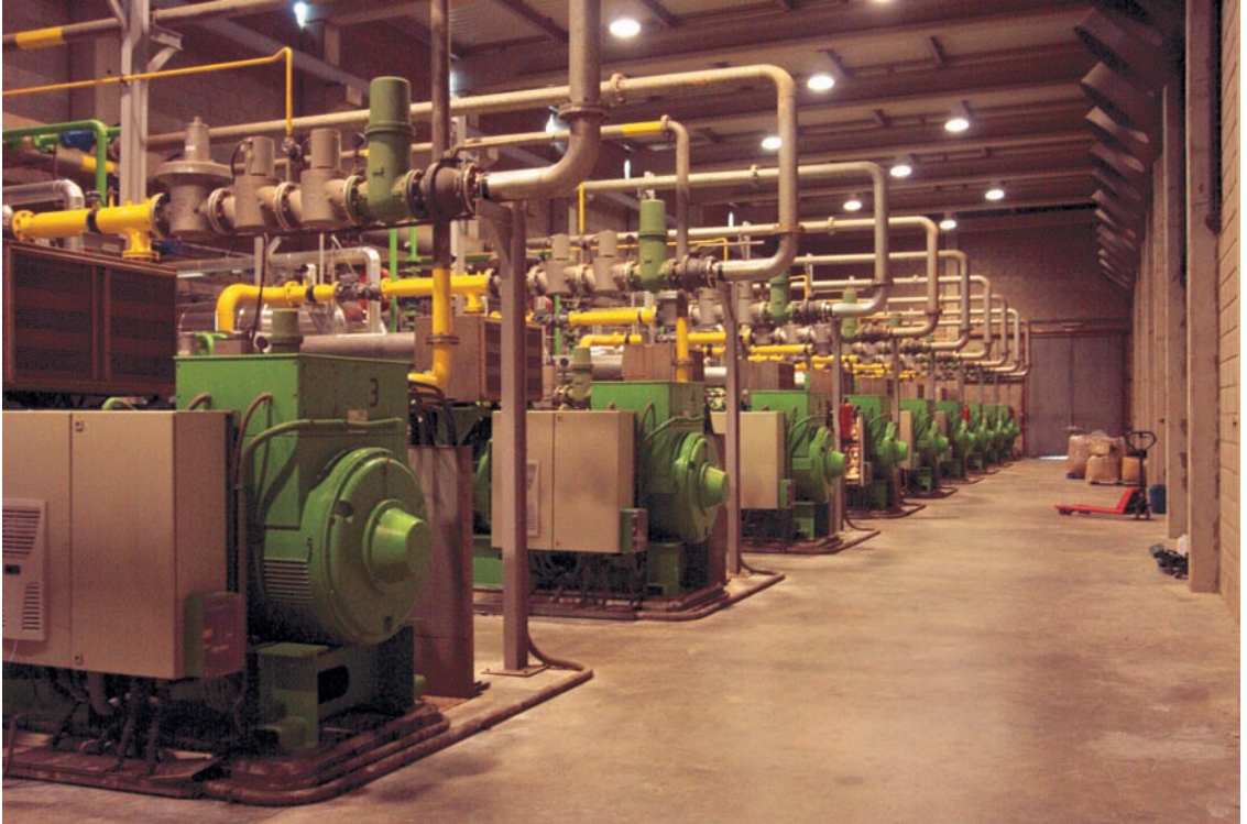
Foto 6.7. Sala de motores.
