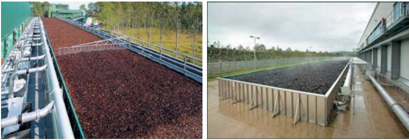
Foto 2.4. Biofiltros colocados en el techo de la planta y en el suelo. (Fuente: ECODECO).
