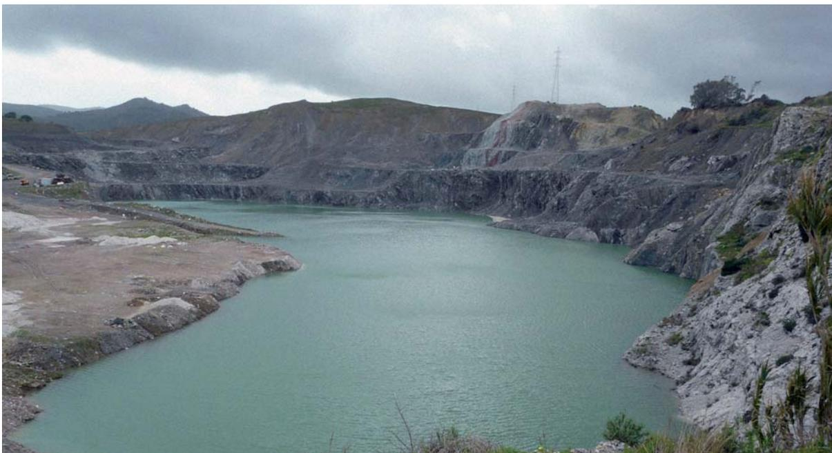
**Foto 42.** Las plazas de las canteras se inundan habitualmente de manera espontánea debido a la acumulación de materiales impermeables o a la compactación del suelo. Circunstancia que facilita la creación de medios acuáticos como parte del proceso de rehabilitación del entorno. J. Elorriaga.
