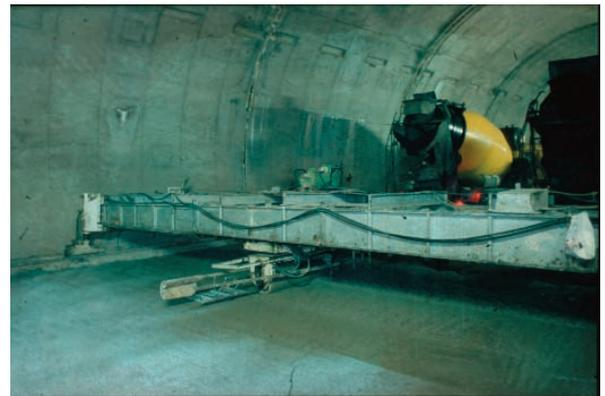
Fig. 17 - Ejecución con acabadora de cilindro (túnel de La Rovira, Barcelona)
