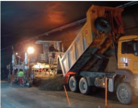
Fig. 19 - Pavimento ejecutado por semianchos con extendidora de encofrados deslizantes
