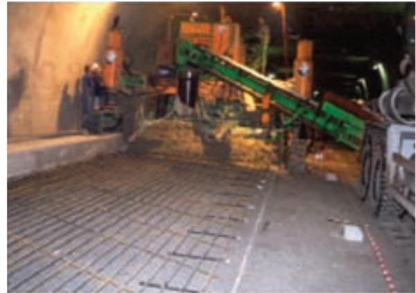
Fig. 25 - Ejecución por semianchos de un pavimento continuo de hormigón armado
