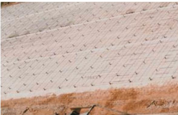
Fig. 26 - Colocación de armaduras de un pavimento continuo de hormigón armado mediante guías en la pavimentadora
