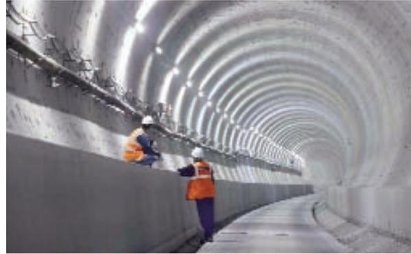
Fig. 18 -Solera de túnel ejecutada con bordilladora
