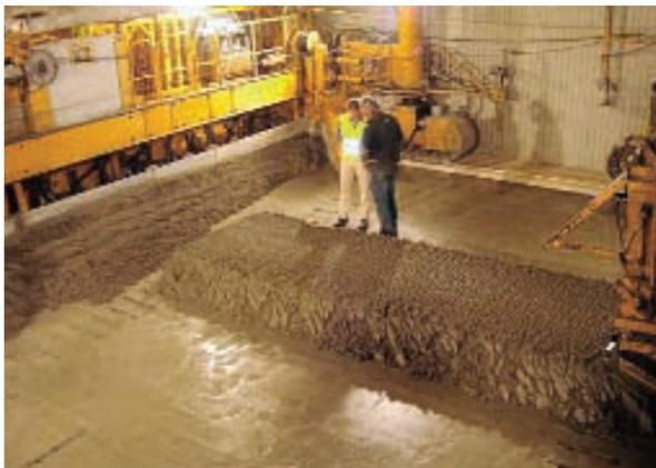
Fig. 23 - Ejecución de pavimento de hormigón en dos capas: alimentación del hormigón de la capa superior
