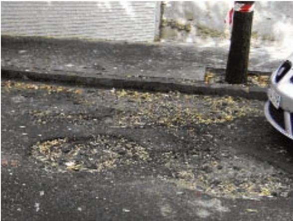
Fig. 9 - Daños causados en un firme urbano por el incendio de un automóvil
