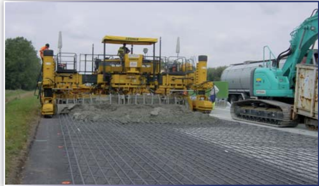
Hormigón armado continuo.
