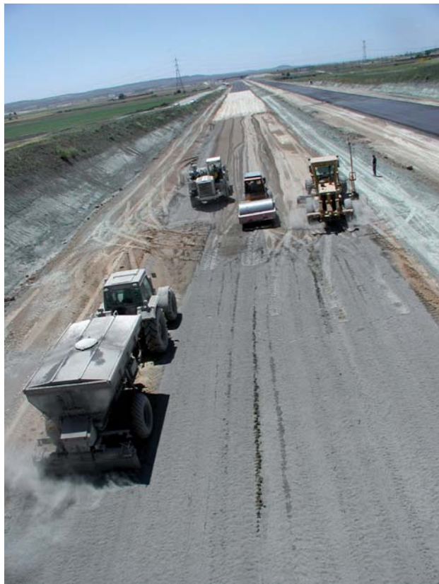
Estabilización de explanada.
