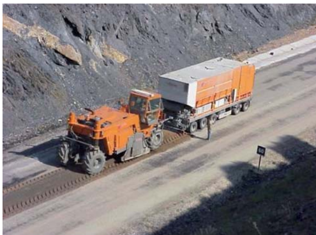
Reciclado con cemento.
