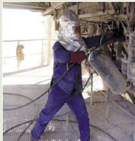
Trabajos realizados en la limpieza y desemboce de ciclones
