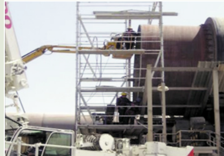
Figura 17. 10. Andamios y plataforma elevadora
