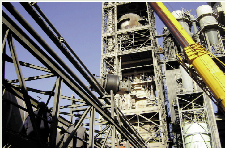
Trabajos no habituales
