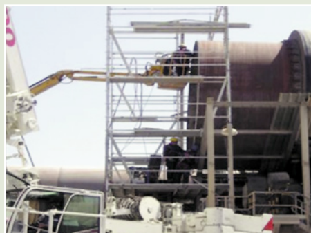
Andamios y plataforma elevadora
