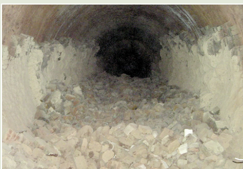
Figura 17. 11. Saneamiento del horno
