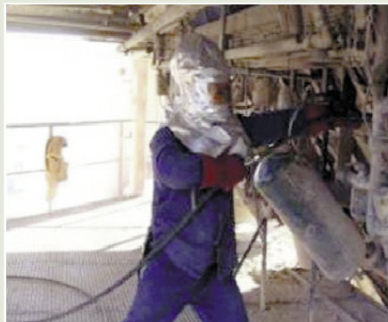
Figura 16. 4. Trabajos con equipos de alta presión
