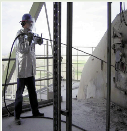
Trabajos realizados en la limpieza y desemboce de ciclones
