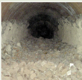
Saneamiento del horno
