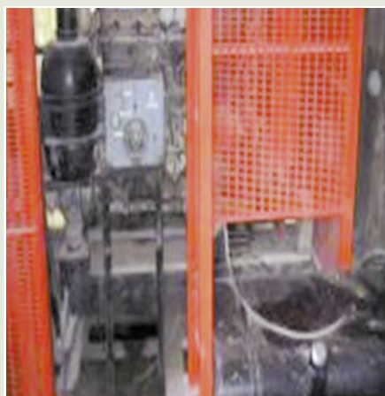
Figura 16. 4. Trabajos con equipos de alta presión
