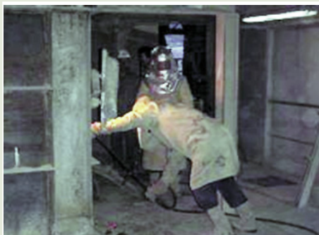
Empleo Equipos de protección
