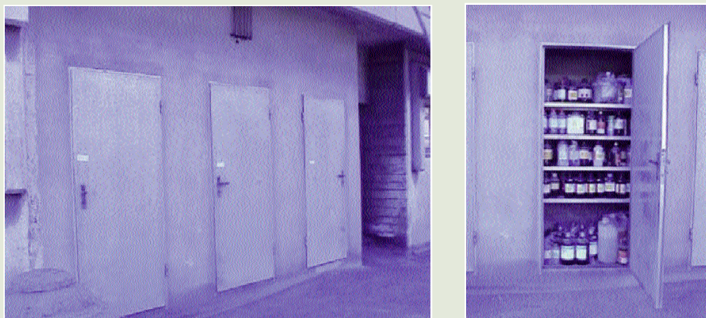
Figura 24. 7. Almacén de productos peligrosos
