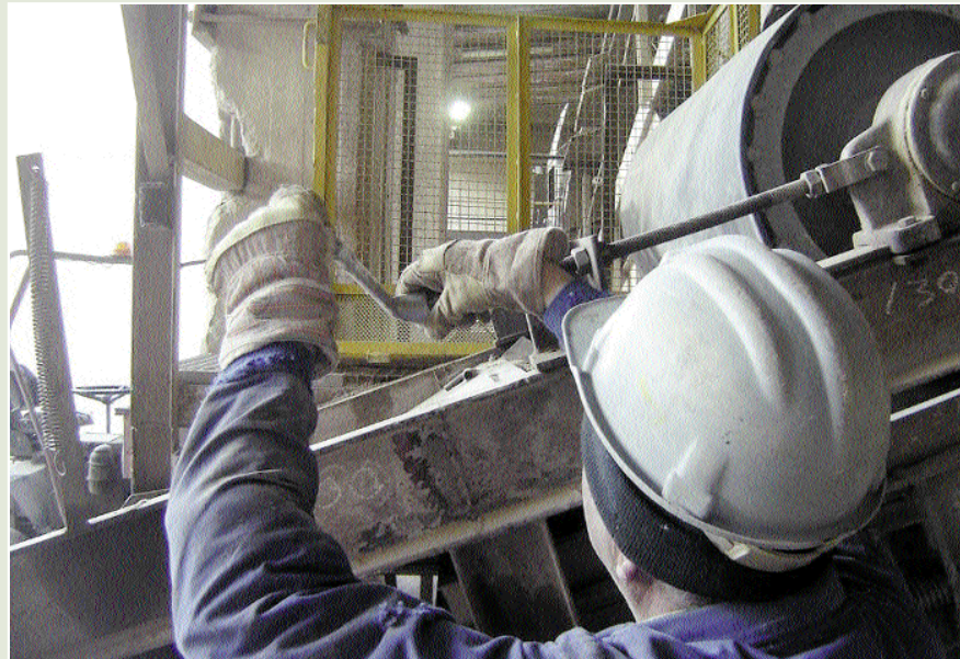
Figura 22. 12. Trabajos de mantenimiento
