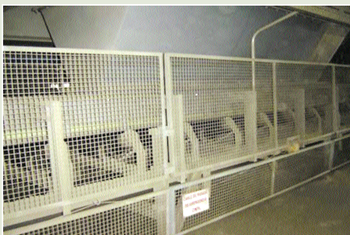
Figura 22. 10. Colocación de carenados
