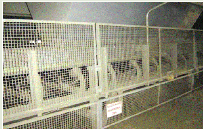
Figura 22. 8. Colocación de carenados
