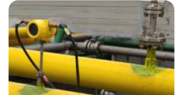
Caudalímetro gas natural e inyector H 2
