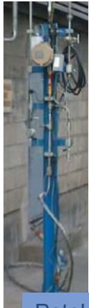
Potelet H 2 conexión del SR a la instalación
